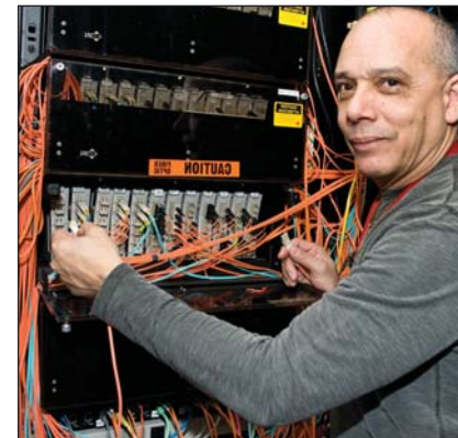
Juan Cuffaro, technicien en informatique, manipule un câble de fibres optiques dans la salle réseau du pavillon principal.
