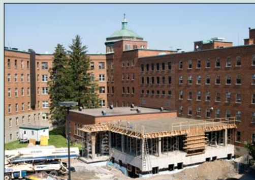
Un aperçu de la construction du CEAMS au mois de septembre 2009.
